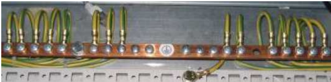
Figura 19 – Linha de aterramento e equipotencial em instalações.
