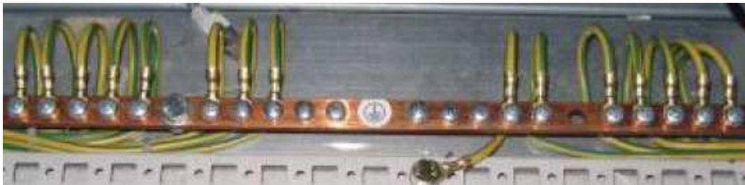
Figura 19 – Linha de aterramento e equipotencial em instalações.
