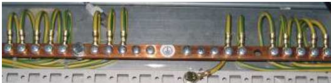
Figura 19 – Linha de aterramento e equipotencial em instalações.
