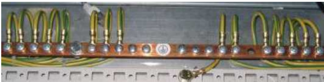
Figura 19 – Linha de aterramento e equipotencial em instalações.
